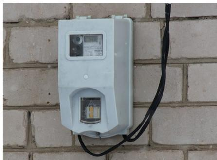
устройствах – кожухах. Такая защита системы исключает малейшие искажения в показаниях счётчиков, как в результате самопроизвольных ошибок, так и в результате внешних воздействий.
